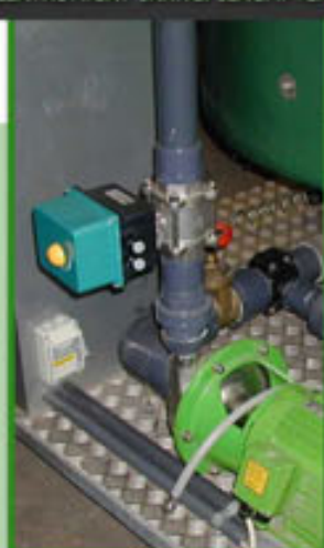
ELEKTRONICKÝ ŠKRTIČÍ SEKČNÍ VENTIL
