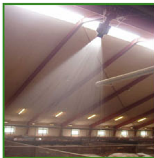
NÍZKOTLAKÉ STACIONÁRNÍ SYSTÉMY BAUER MICROSPRAYMATIC (sprchování) 60 Pa
